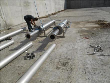
Gruppo di spinta composto da 4 pompe in parallelo, portata complessiva di 540 m<sup>3</sup>/h, mantelli di raffreddamento e tubazioni d'alimentazione impianto di potabilizzazione in acciaio inox
