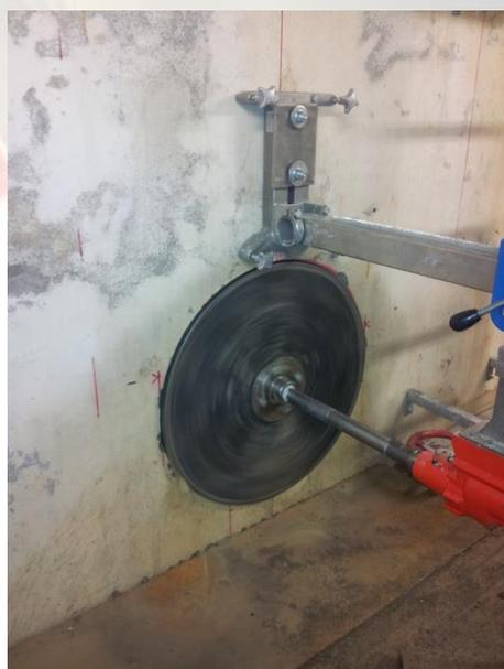
L'accesso viene realizzato mediante una carotatura da 800 cm nella parete del serbatoio. **Il foro passante viene realizzato in un'unica soluzione mediante apposita fresa.**
